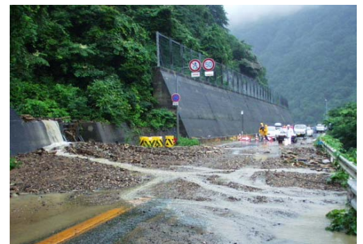
▲国道47号猪ノ鼻地区の被災状況
