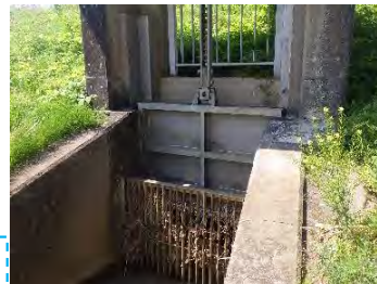
↑ 排水樋管の操作訓練状況
