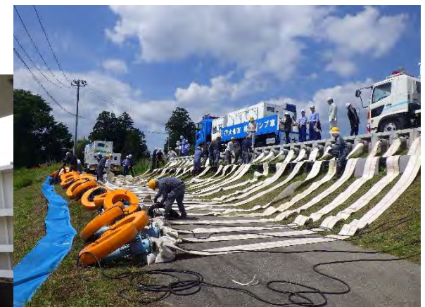
↑ 排水ポンプ設置状況
