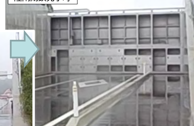
陸閘閉鎖完了時
