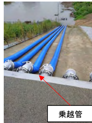
西仙北・大沢川樋門
