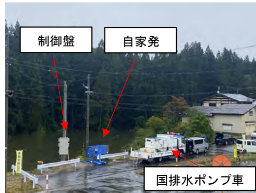
協和・小平沢排水樋門
