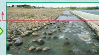
改築後の大久保堰(H18.3完成)の左岸魚道状況
