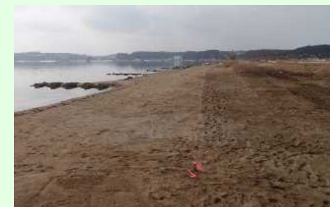
養浜による水質負荷軽減 （上：整備前、下：整備後）
