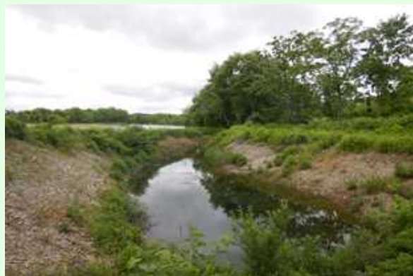
【自然再生】ワンドの新設（B地区事業対象箇所）
