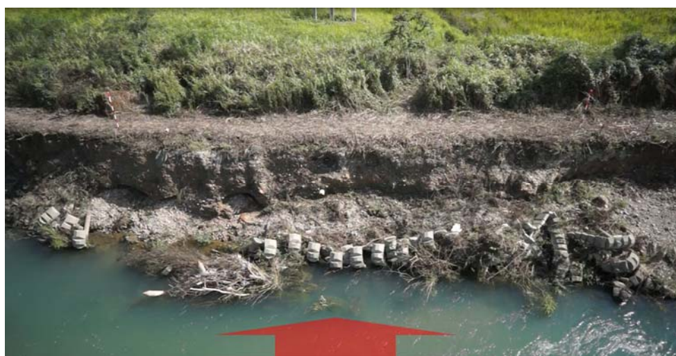
ドローンの機動性を活かした川側からの撮影画像
