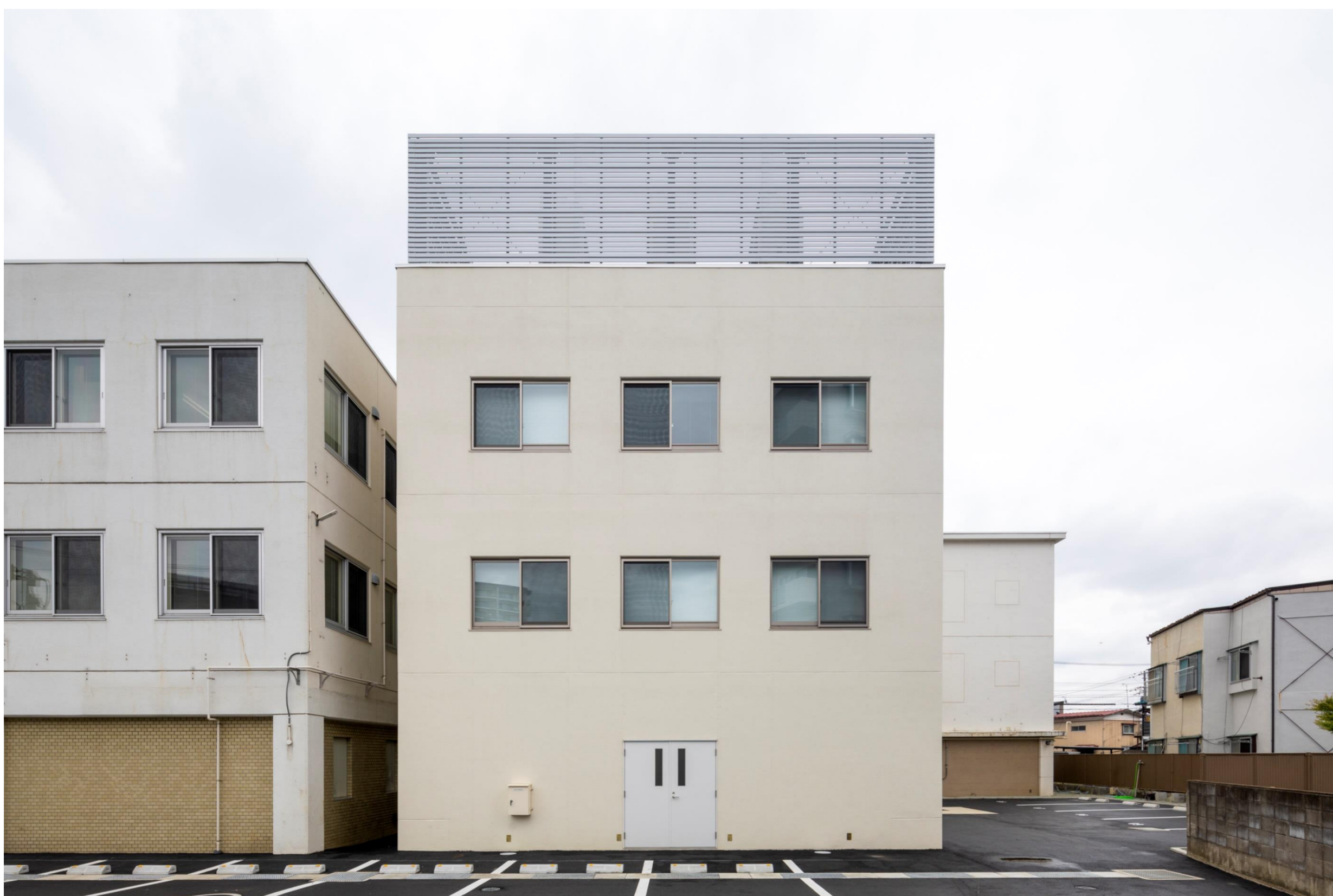
[敷地北西側から増築庁舎を望む]
