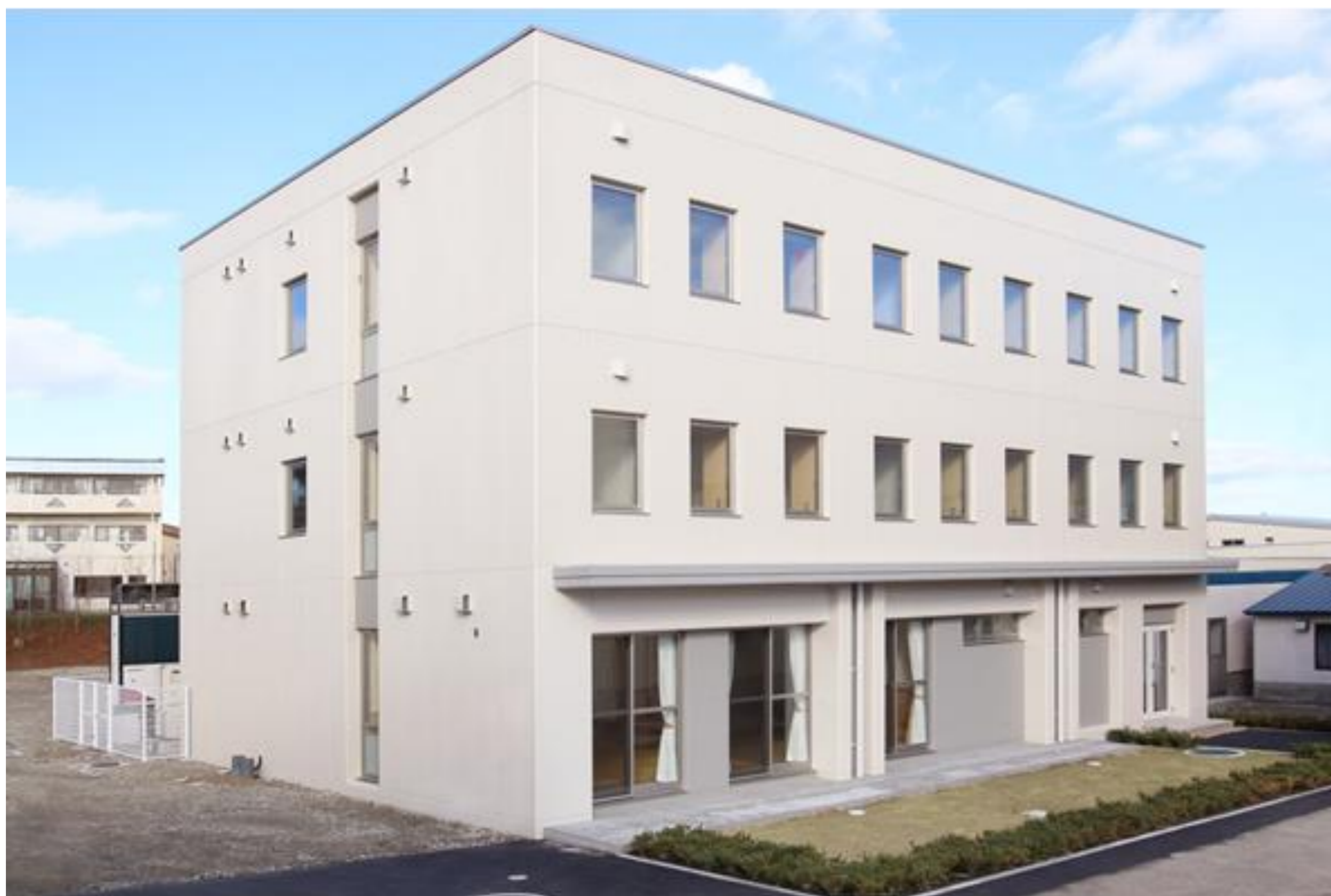
〔構内駐車場から生徒寮南西側を望む〕
