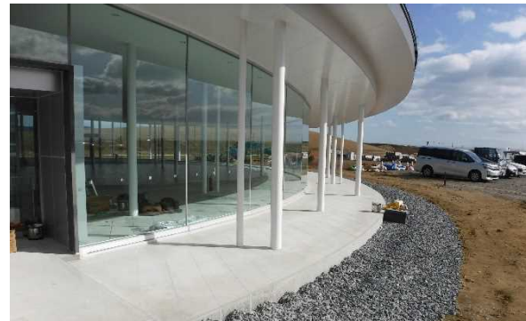
(写真) 伝承館外部の円環テラス
