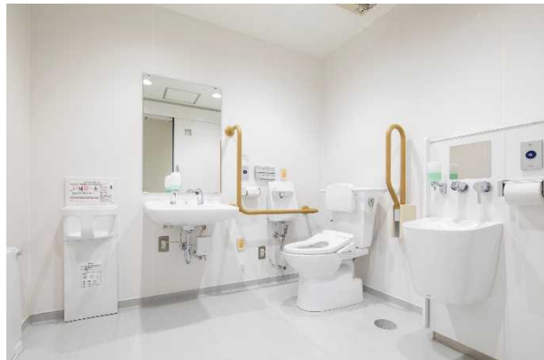
(写真) 既存庁舎 ゆったりとした多目的便所 オストメイト、ベビーベッド、ベビーチェア、フットボードを備え、どんな方でも利用可能です。
