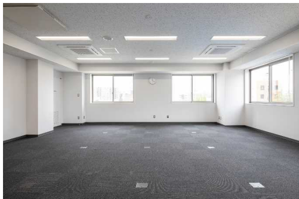
(写真) 増築庁舎 フレキシブルに利用可能な会議室 床は将来の部屋用途の変更にも対応したOAフロアとしフレキシブルな空間となっています。
