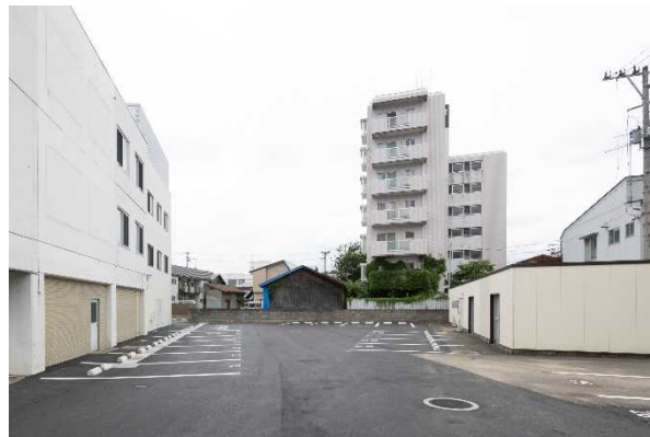
(写真) 北側駐車場 より多くの駐車台数を確保。
