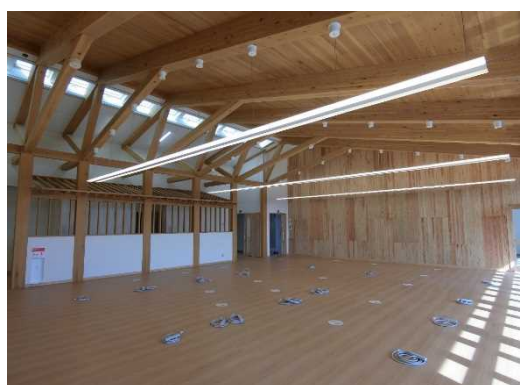
【2階執務室（CLT、タスクアンビエント照明）】
