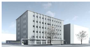
福島第2地方合同庁舎 外観イメージ
