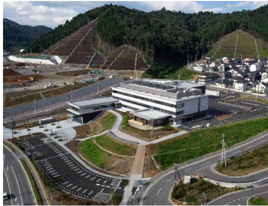
【女川町庁舎 全景】
