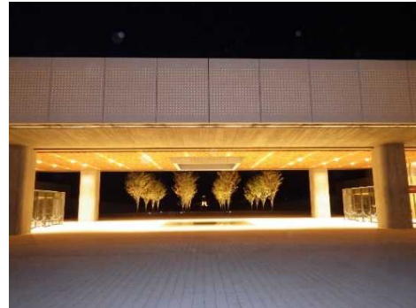
(写真) 水盤のあるピロティー（夕景） 上部はホワイトコンクリート PC パネルにて構成。 北面の 18,434 の穴は東日本大震災の犠牲者数を表し、暗くなると裏面に設置した照明の光が漏れる。
