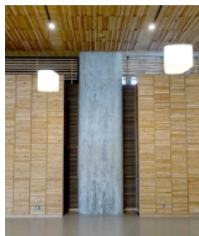
(写真) コンクリート柱と木質壁・天井 施設の特徴である杉板型枠を使用した コンクリート柱
