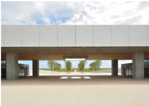
(写真) 水盤のあるピロティー ピロティーを抜けて「海を望む場」へつながる「祈りの軸」
