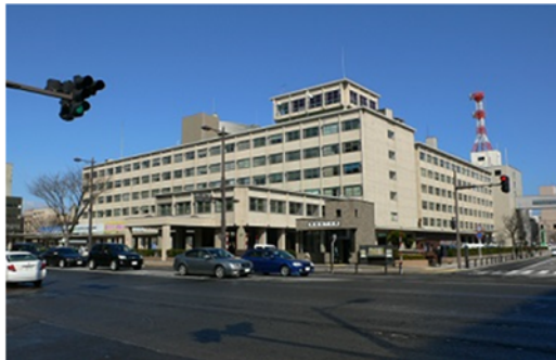
【改修前の県庁舎（平成26年3月撮影）】
