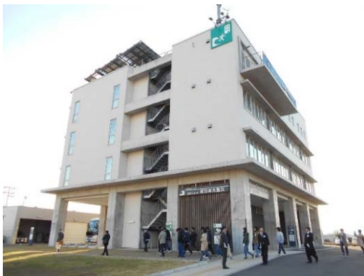
〔石巻港湾合同庁舎（国施設）〕
