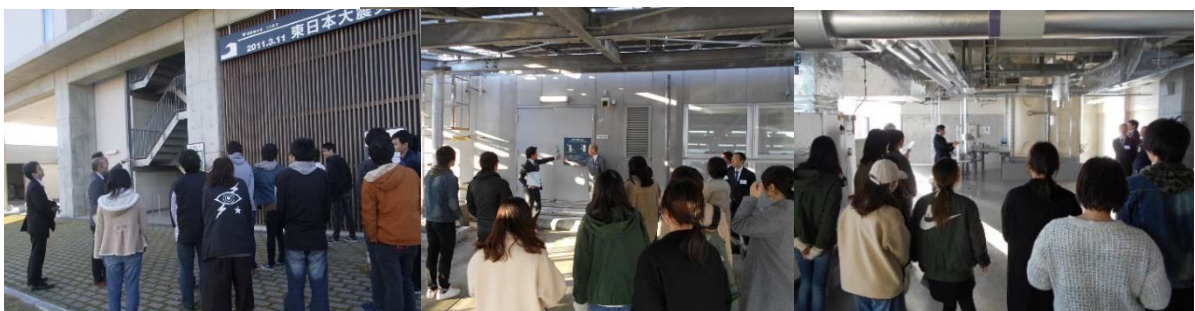
〔石巻港湾合同庁舎(国施設) 見学状況（左：外壁・浸水高さ表示、中：屋上避難スペース、右：機械室）〕
