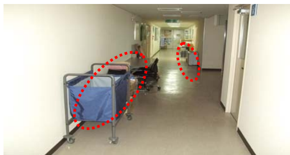
避難通路(廊下)状況
