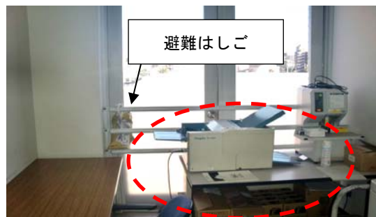
室内避難口状況
