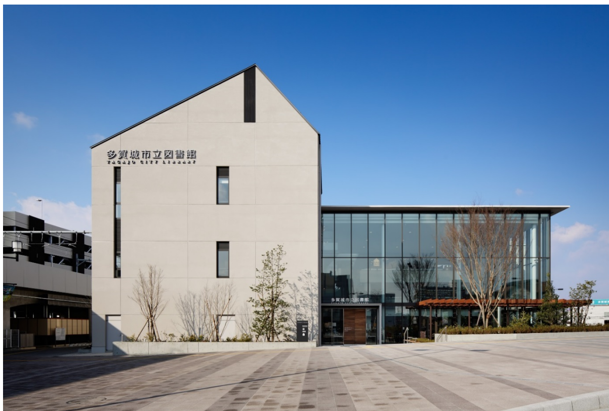
【多賀城駅北ビルA棟】
