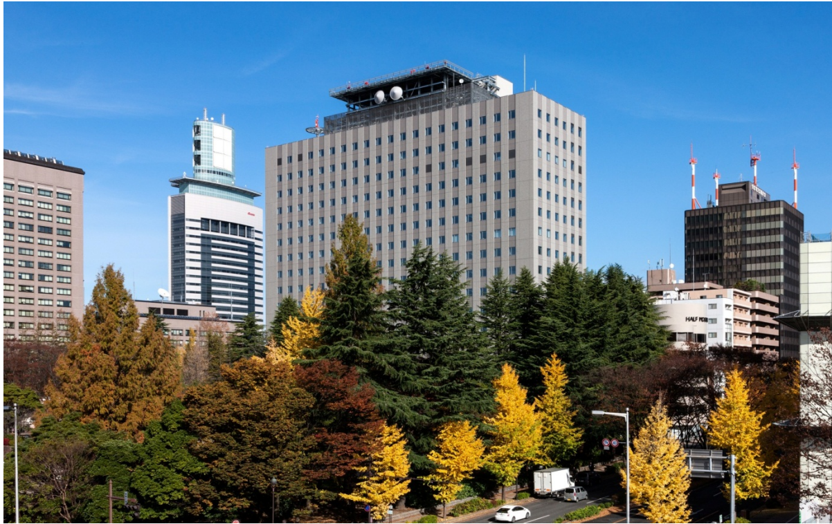
【昨年11月に完成した仙台合同庁舎B棟】 東北地方整備局も11月24日、こちらに移転しました。
