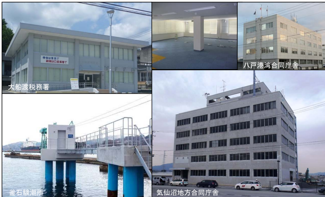
東日本大震災の津波被害から復旧した施設
