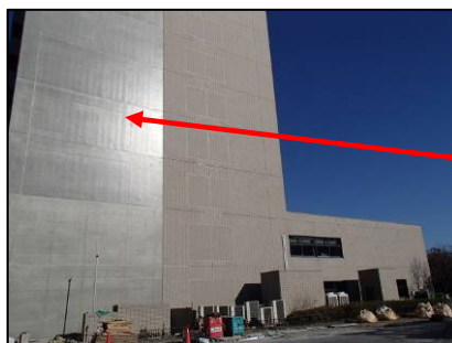
構造補強フレーム設置後
