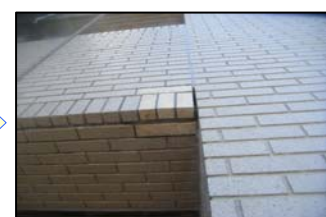
外壁復旧状況
