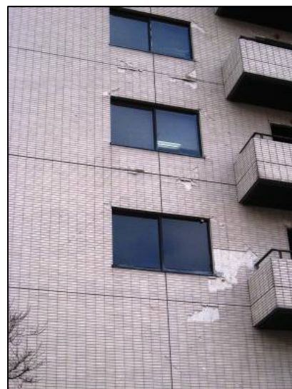
外壁の損傷
