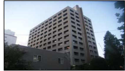
庁舎復旧状況
