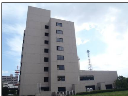
構造補強フレーム設置前
