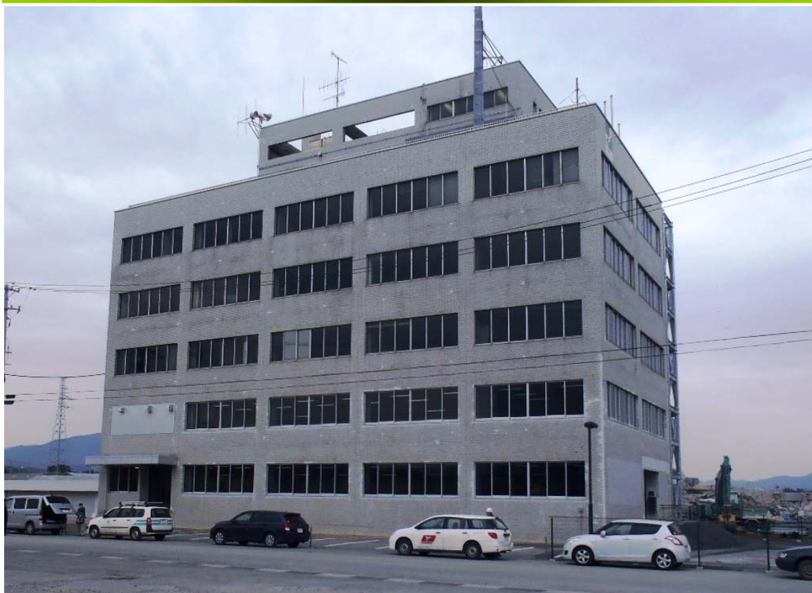
東日本大震災で津波浸水被害を受け、復旧工事を行った気仙沼地方合同庁舎
