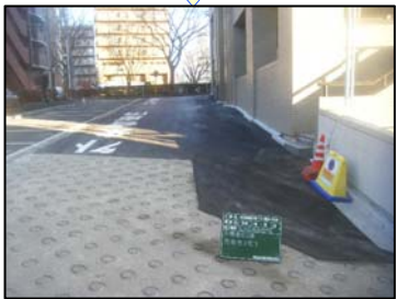
外構の復旧状況
