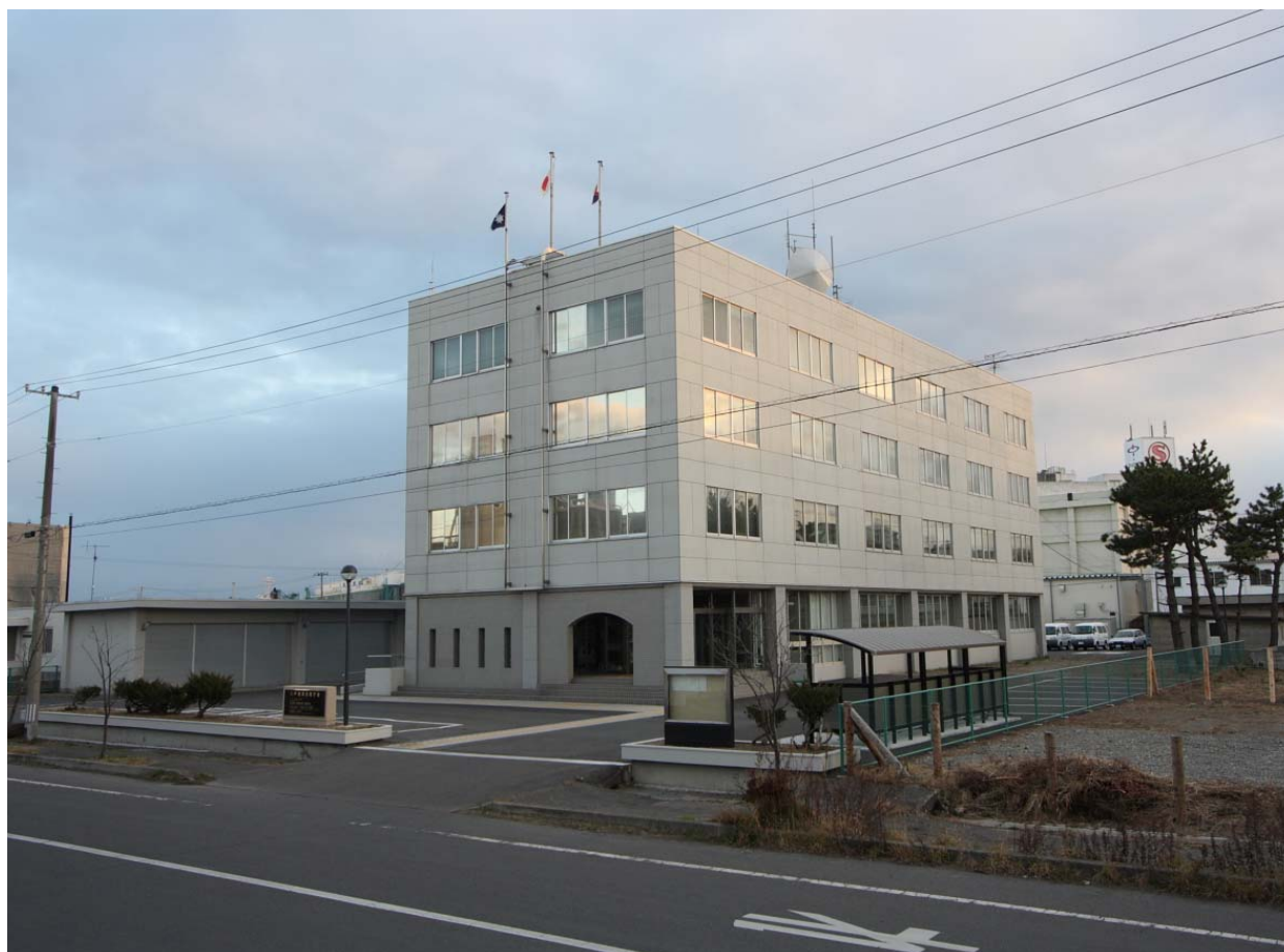
東日本大震災で津波浸水被害を受け、復旧工事を行った八戸港湾合同庁舎
