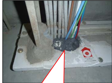
使用している処理材の材質が不適切
