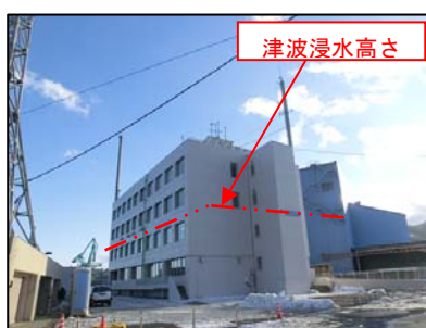
外部復旧状況
