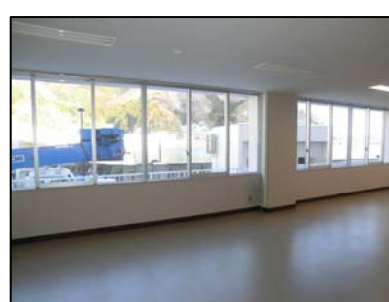
庁舎内部復旧状況
