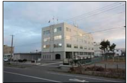
庁舎復旧状況
