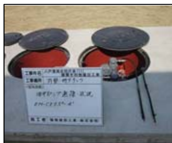
燃料ポンプ整備状況
