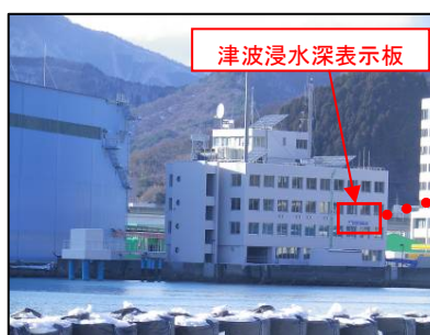
庁舎復旧状況
