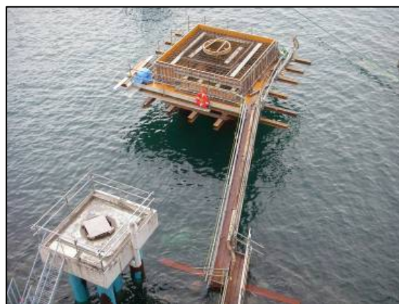
仮設構台の設置状況
