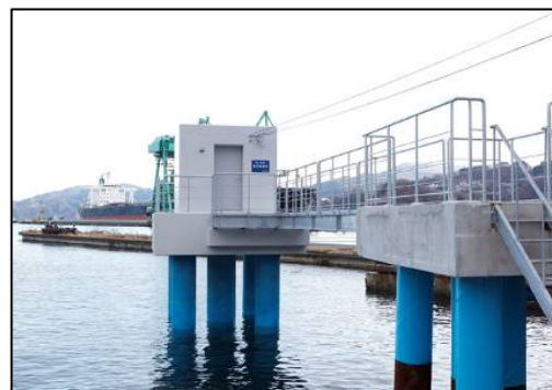
復旧した釜石験潮所
