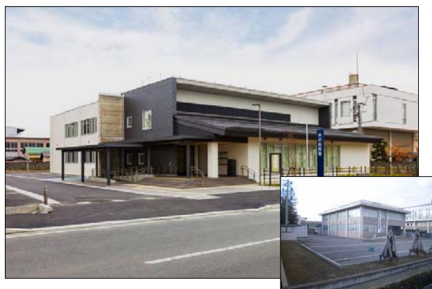
増築後 外観 南東側(右下旧庁舎)
