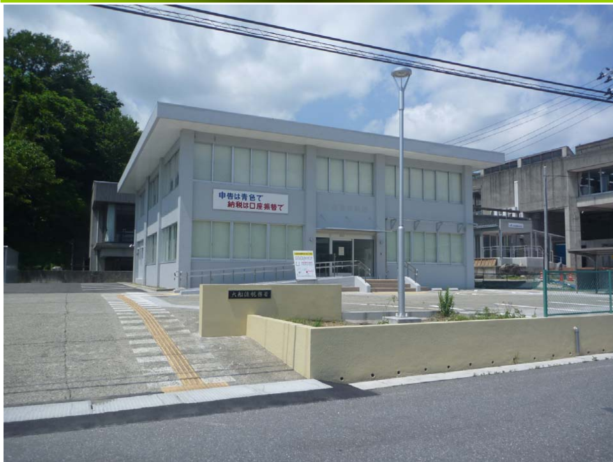
東日本大震災で津波浸水被害を受けたため、復旧工事を行った大船渡税務署
