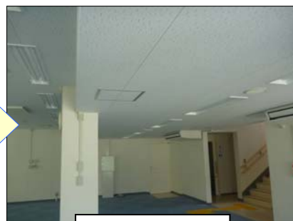
内部復旧状況
