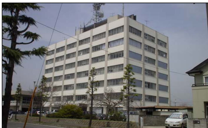
耐震改修を行う塩釜港湾合同庁舎(継続事業)
