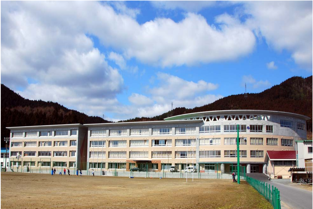
岩手県立大船渡東高等学校（校舎・産振棟：平成21年3月完成）
