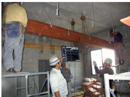
鉄骨小梁設置による床補強
