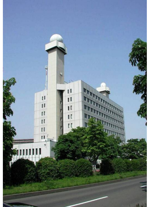
仙台第3地方合同庁舎
