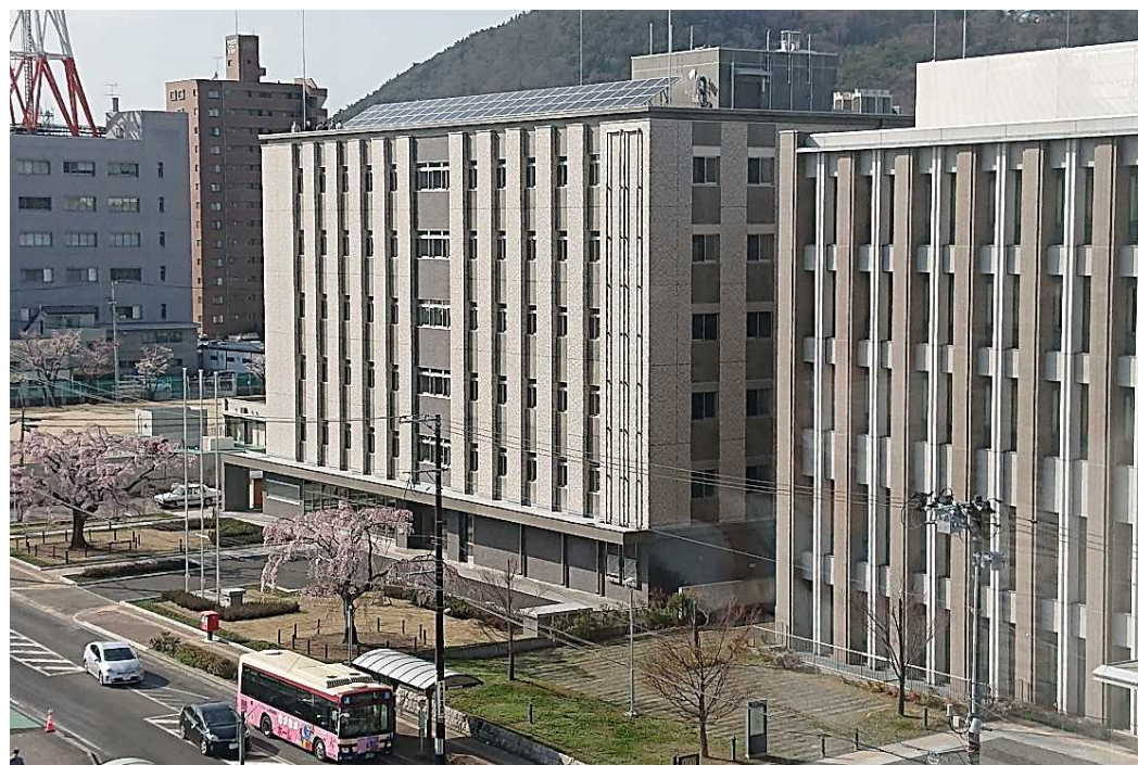
建物外観（左が完成した福島第二地方合同庁舎、右は福島地方・家庭裁判所）
