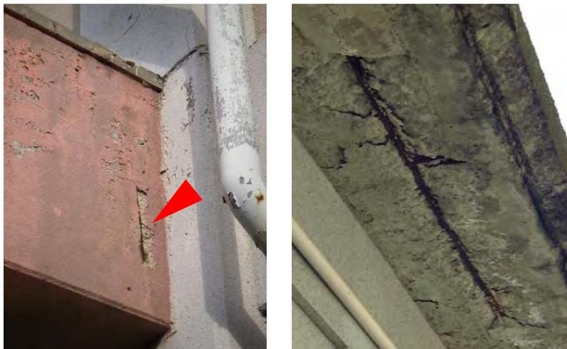
【外壁躯体の欠損・鉄筋の露出】
