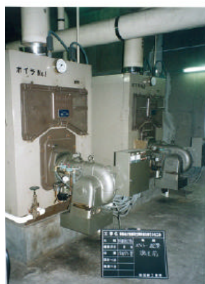
・撤去前の既設のボイラー及び温水配管
