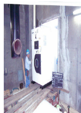
・新設ボイラーの外部入口よりの搬入状況
