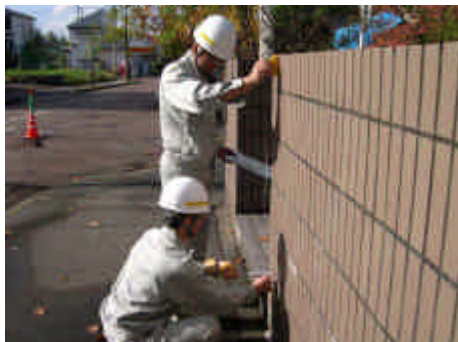
塀の傾きを測定
