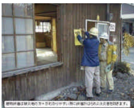
判定ステッカーの貼り付け(訓練)
