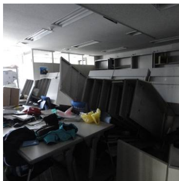
二段式家具の落下と転倒
