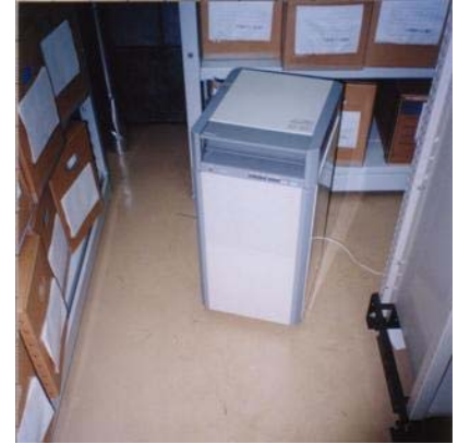
【除湿機の設置】
