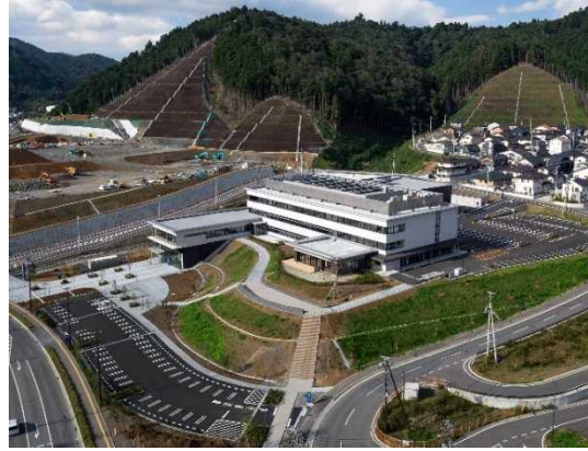
[女川町庁舎 全景]
