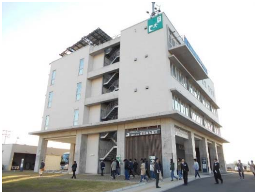
〔石巻港湾合同庁舎（国施設）〕
