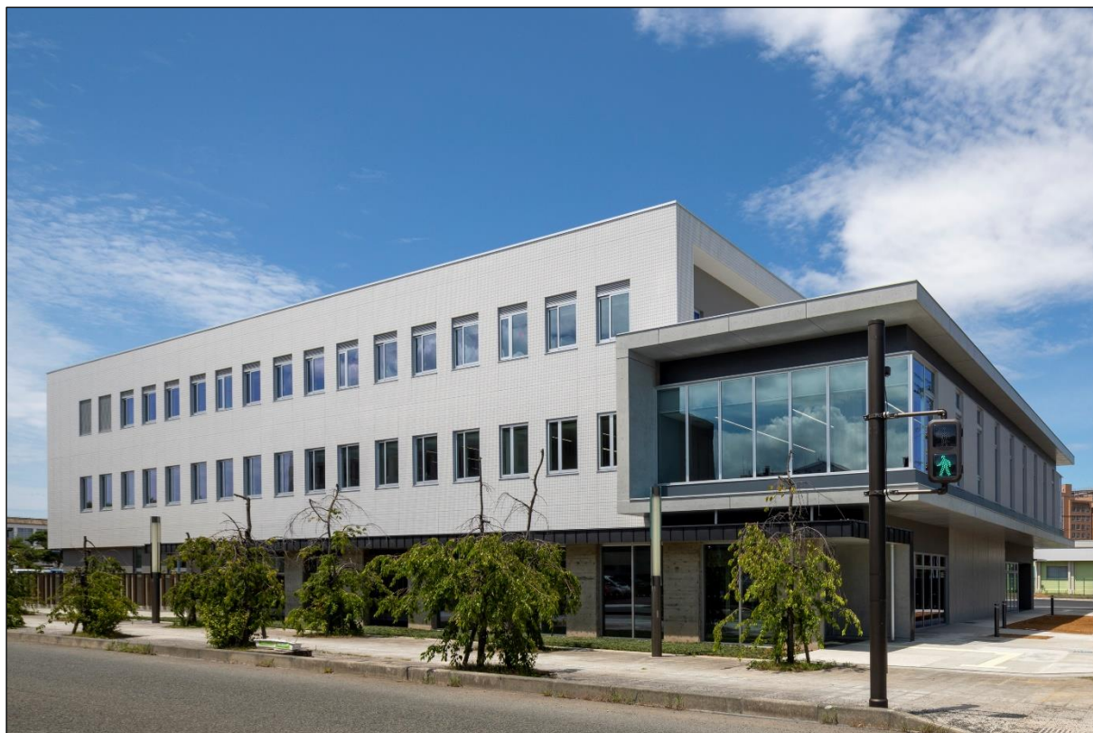
<写真①>庁舎南側外観
