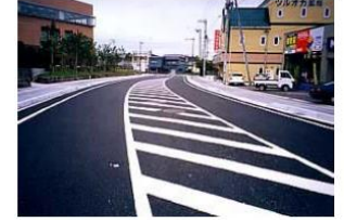
⑥ 都市計画道路鳥居町新斎部線 H15.7完成
