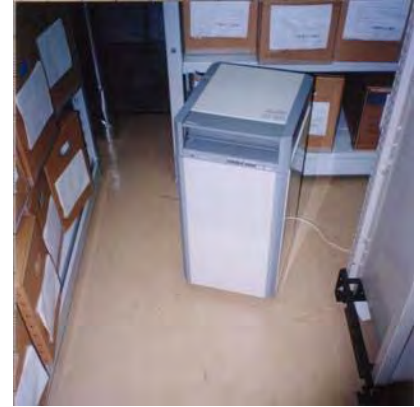
【除湿機の設置】
